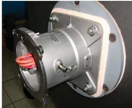
2) Смонтировать Смесительную Группу на котле;
