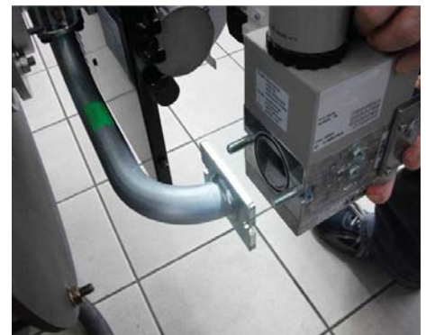
9) установить электроклапан на Труба ГАЗОВОЙ рампы;
