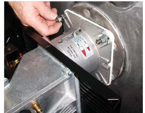
6) Зафиксировать горелки на котел;
