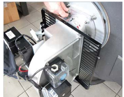
6) Зафиксировать горелки на котел;
