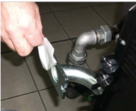
7) Снять заглушку из Труба ГАЗОВОЙ рампы;
