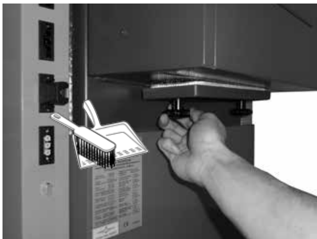
Чистка дымового канала в задней части котла
