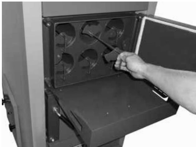
Очистка трубчатой доски котла с помощью вставленного замедлителя
