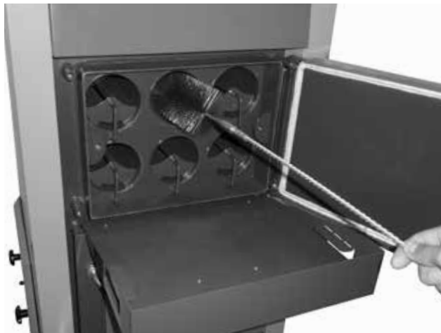
Очистка трубчатой доски с помощью щетки
