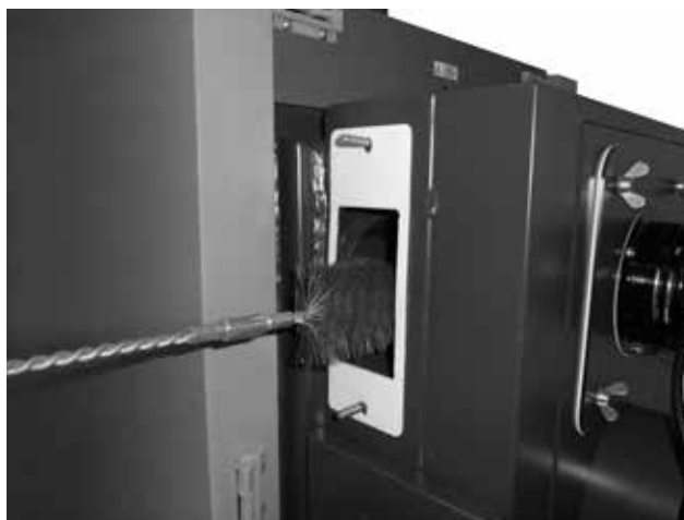
Чистка дымового канала. Выполняется после очистки трубчатой доски выше топке котла
