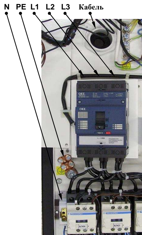
Рис. 21. Подключение входного кабеля котла «Daline PTE 22 – 60»
